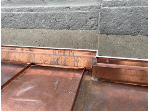
neues Kupferblech auf Kranzgesims
