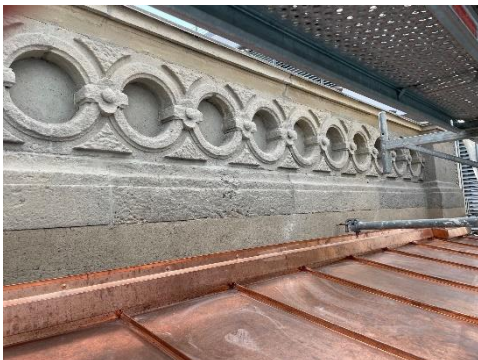
Restaurierter Zustand vor Abrüstung
